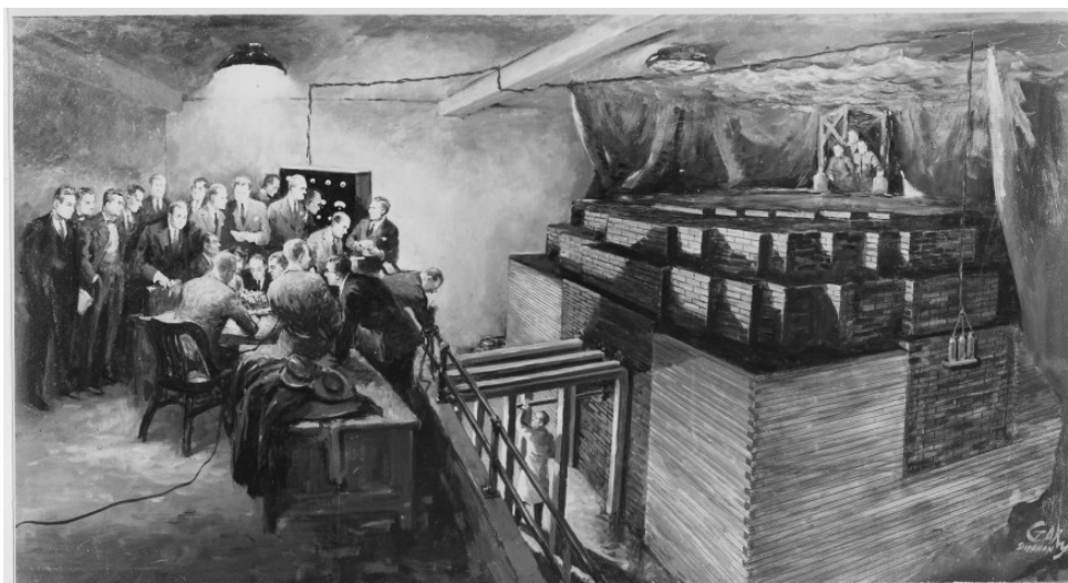
7: prosinec 1942 Chicago – kresba zachycuje spuštění prvního jaderného reaktoru. Všimněte si ruční manipulace s regulační tyčí. Autor obrázku: Gary Sheehan (1957) [Wikimedia Commons].
