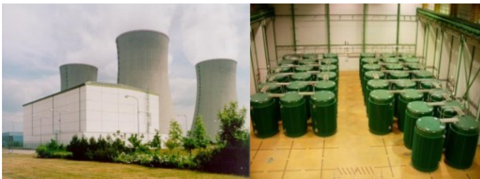
23: Suchý mezisklad použitého jaderného paliva v areálu jaderné elektrárny Dukovany Obrázek ČEZ, a.s.
