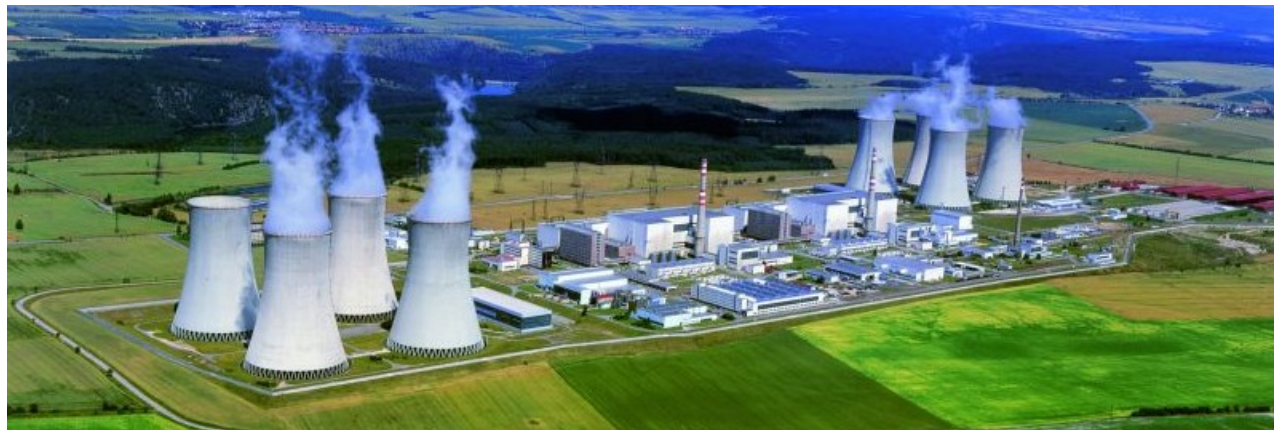
14: Celkový pohled na areál jaderné elektrárny Dukovany Fotografie: [ČEZ, a.s., 2007].
