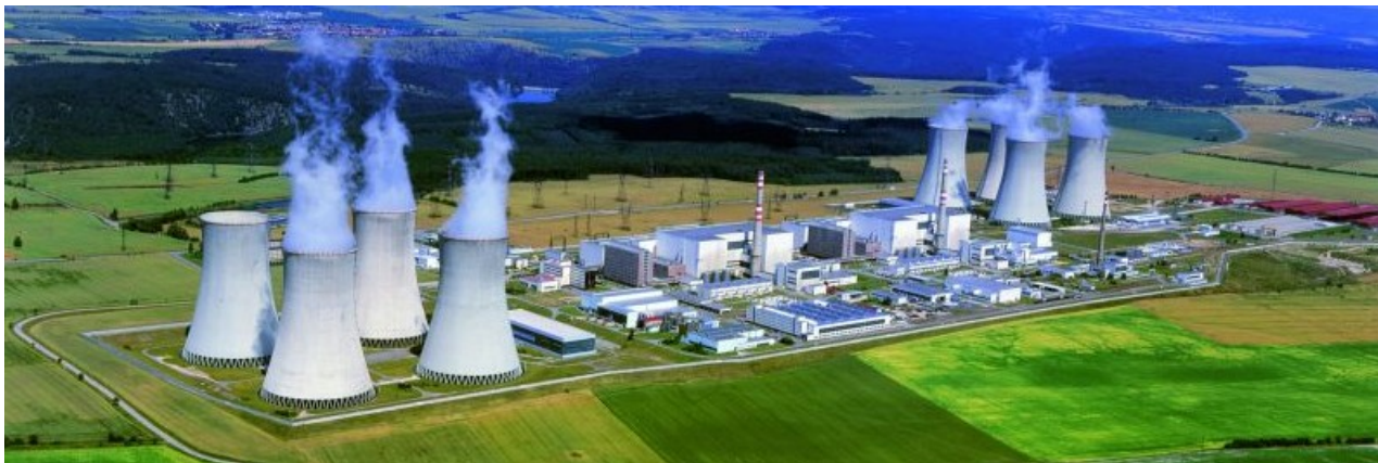
Celkový pohled na areál jaderné elektrárny Dukovany Fotografie: [ČEZ, a.s., 2007].
