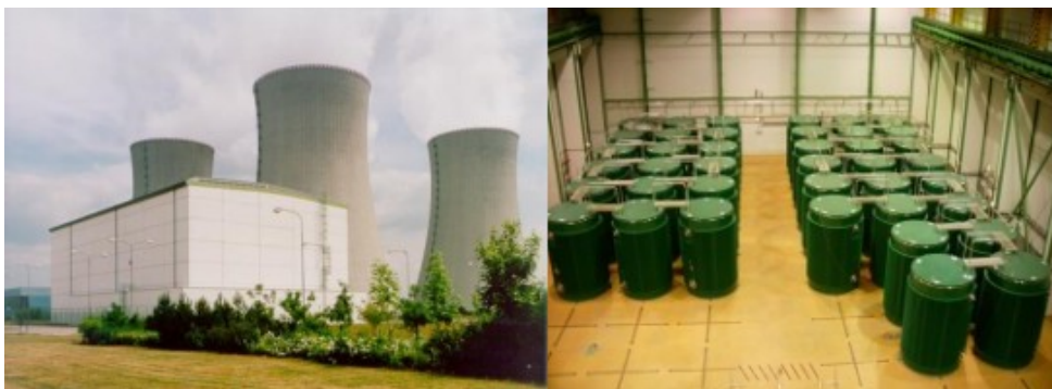
Suchý mezisklad použitého jaderného paliva v areálu jaderné elektrárny Dukovany. [ČEZ, a.s.]
