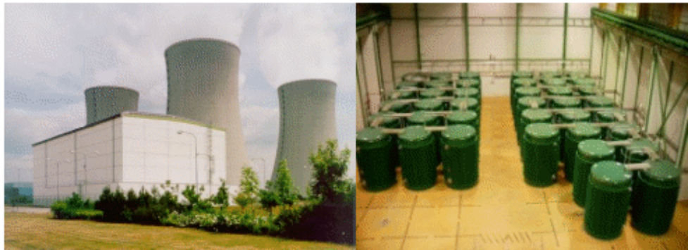
533 Suchý mezisklad použitého paliva v areálu jaderné elektrárny Dukovany, [4]
