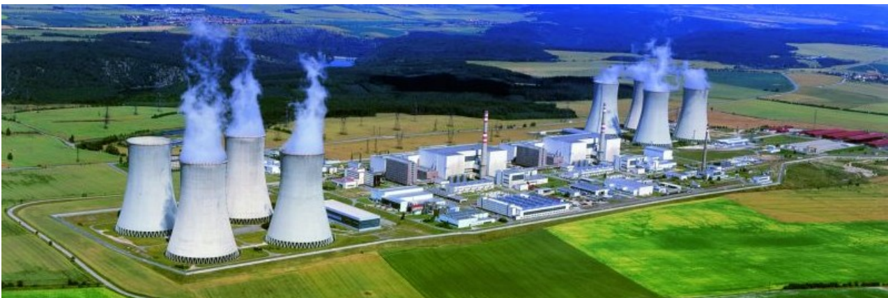
528 Celkový pohled na areál jaderné elektrárny Dukovany Fotografie: [4, 2007].
