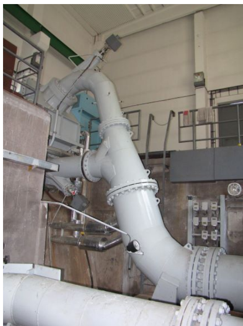
530 Peltonova turbína pro regeneraci potenciální energie v jaderné elektrárně Temelín
